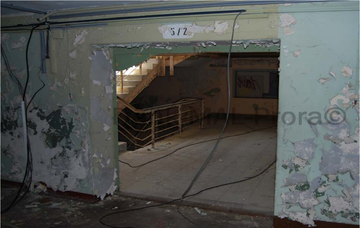
Blick in Richtung Treppenhaus 5:
