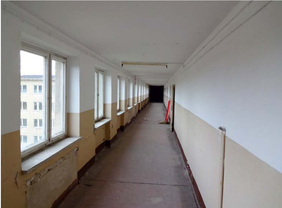
Gang, der in den leider nicht mehr zugänglichen Stasitrakt führt.
