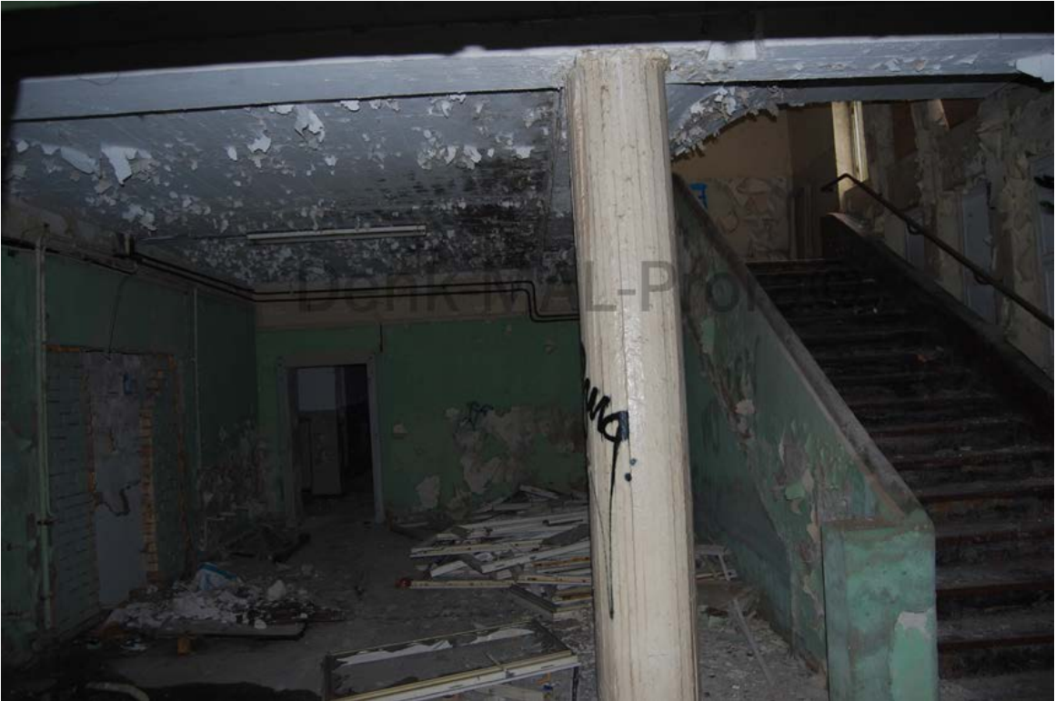
Das Treppenhaus (TH) 2 im Jahr 2014:
