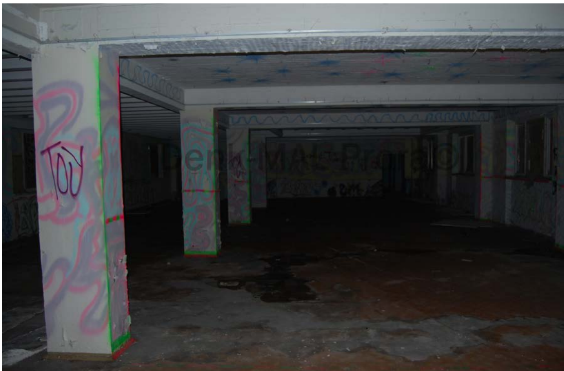
Abermals ein Saal, hier mit Linoleumbelag. Im Anschluss daran (s. unten) seeseitig ein kleinerer Saal.
