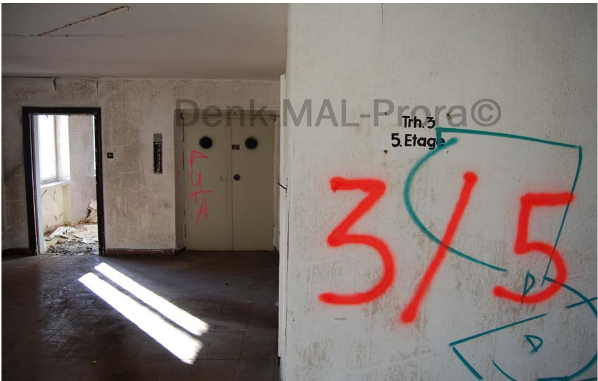
4. OG. = 5. Etage: Flur im Treppenhaus 3 mit Personenaufzug:
